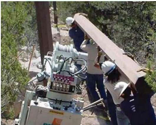
شکل ۲ - حمل تیر پلی‌مر تقویت شده با فیبر، روی شانه به محل نصب
