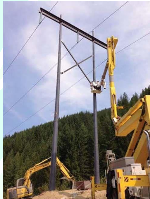
شکل ۳ - کمربند تقویتی با مواد پلی‌مری تقویت شده با فیبر که در یک سازه نوع H به کار رفته
