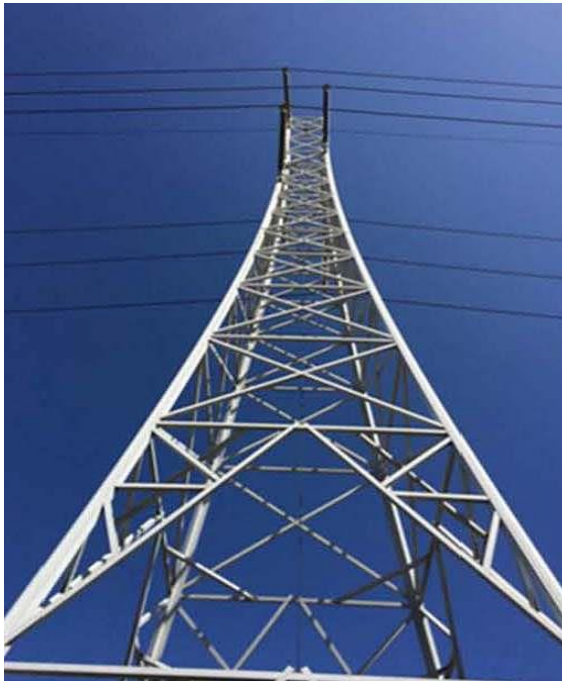
شکل ۴ - سازه مشبک خط ۲۳۰ کیلوولت پلی‌مری تقویت شده با فیبر
